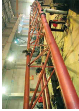
3.4.4 pav. Utenos m. daugiafunkcinio sporto komplekso sporto salės stogo denginio virintinės metalo konstrukcijos gamyba (UAB „Kauno energetikos remontas“, 2009)
